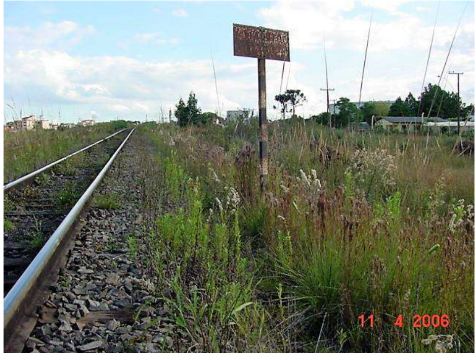
Placa de sinalização para o maquinista ilegível.
