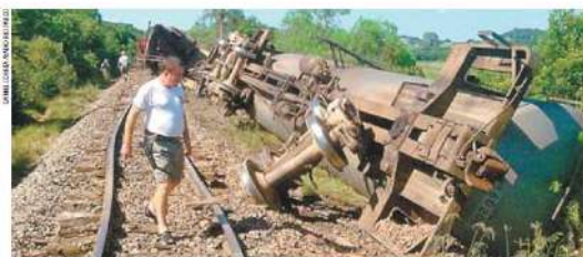
DESCARRILAMENTO possui como uma das causas mais prováveis a dilatação dos trilhos com o forte calor do outono
