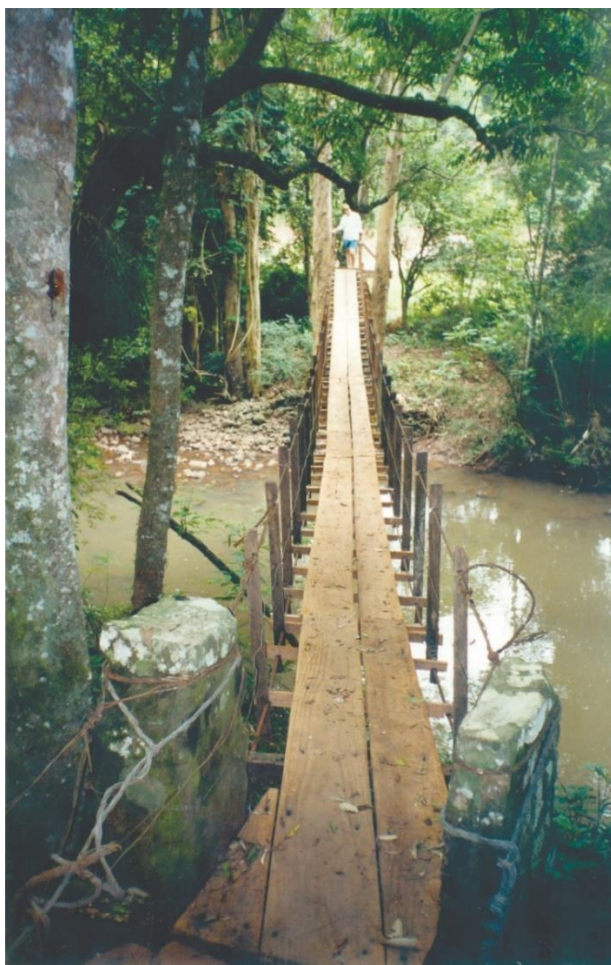
Ponte pênsil sobre o ar. da Secca. Foto: Erny Mügge.
